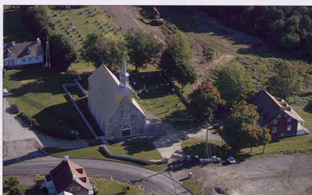
Le réaménagement des abords de l'église Saint-François et du tracé de la route au cœur du village.
